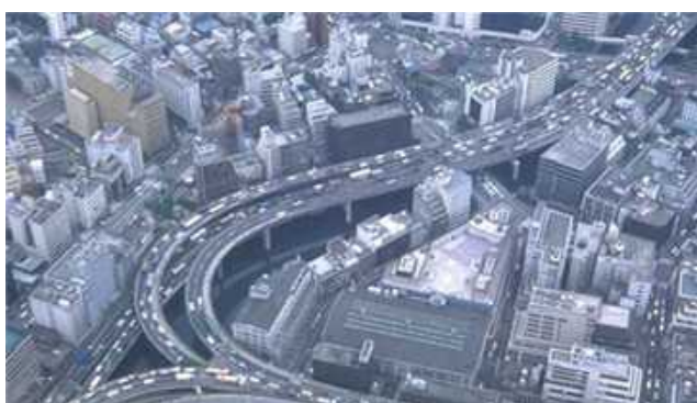
La devastazione dei corsi d'acqua a Tokyo.
