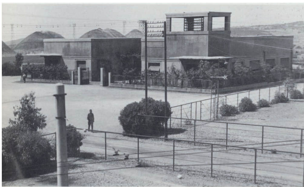
LA PALAZZINA DELLA DIREZIONE AMMINISTRATIVA DELLA GRANDE MINIERA DI SERBARIU VICINO A CARBONIA.
